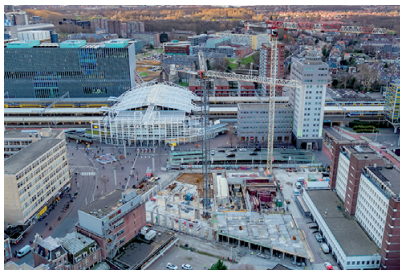
Stationsgebied in aanbouw
